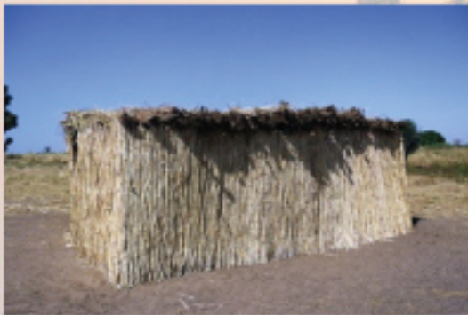
Der Behelfsklassenraum entstand 2011
